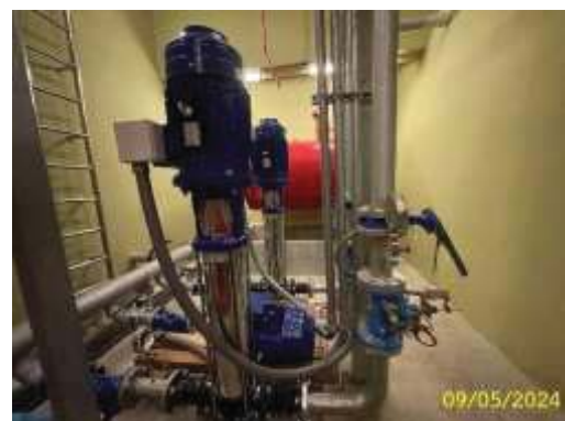
เครื่องปั้มน้ำสำหรับอุปโภค-บริโภค ชั้นใต้ดิน
