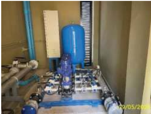
เครื่องปั้มน้ำสำหรับอุปโภค-บริโภค ชั้นดาดฟ้า
